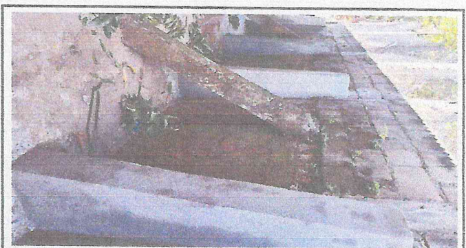
Foto 4: Refuerzo de Pared Perimetral
