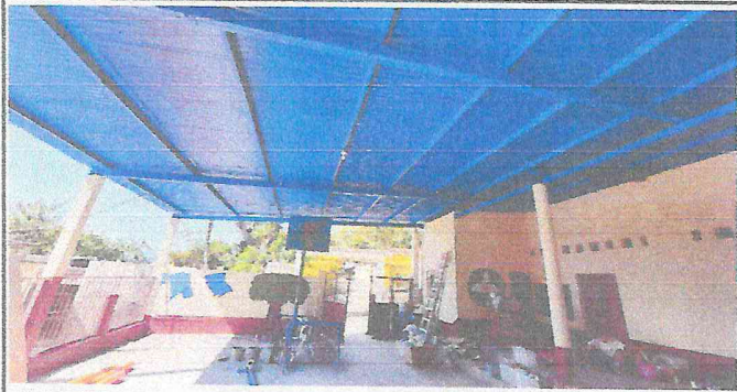
Foto 1: Estructura Metalica Completa
